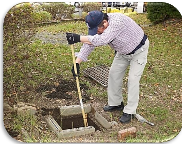
中腰の作業はきついです!
