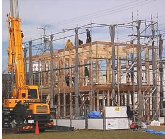
上棟作業が始まり!
