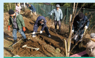
コミュニティ広場奥でインターロッキングの敷設
