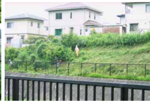
住宅地作業中
