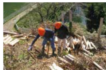
定例の作業日での作業道の作設
