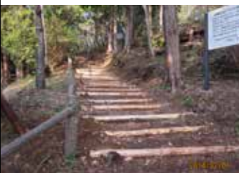
散策路の階段修復
