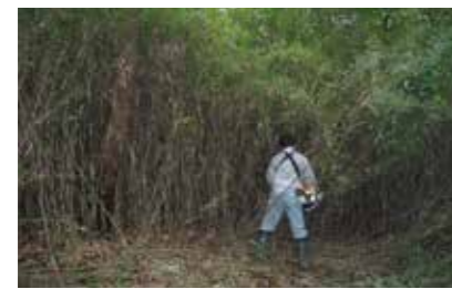
小学校付近着手前
