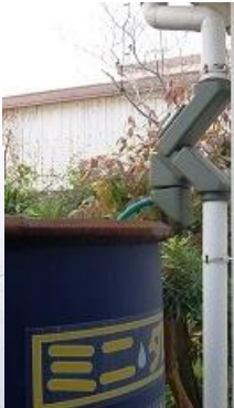
屋根からの雨水を溜める 200ℓタンクとトイレの 分岐(右)
