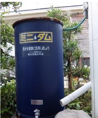
屋根からの雨水を溜める 200ℓタンクとトイレの 分岐(右)
