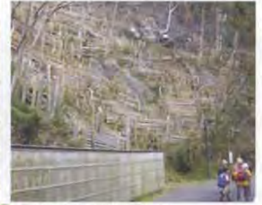
施工後(焼津市花沢地区)
