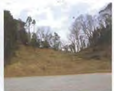
施工後(掛川市湧水)
